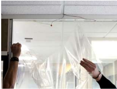
13. Entfernen Sie den äußeren Schutzliner von der aufgetragenen Folie
